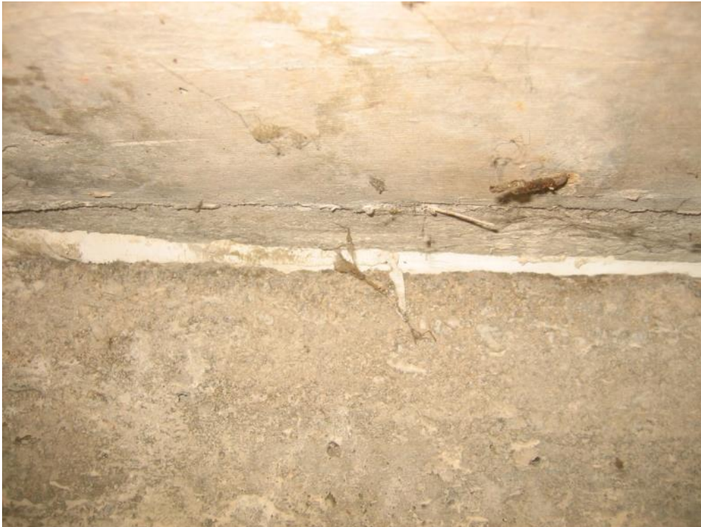
Abb. 25 Gleitfolie am Auflager
