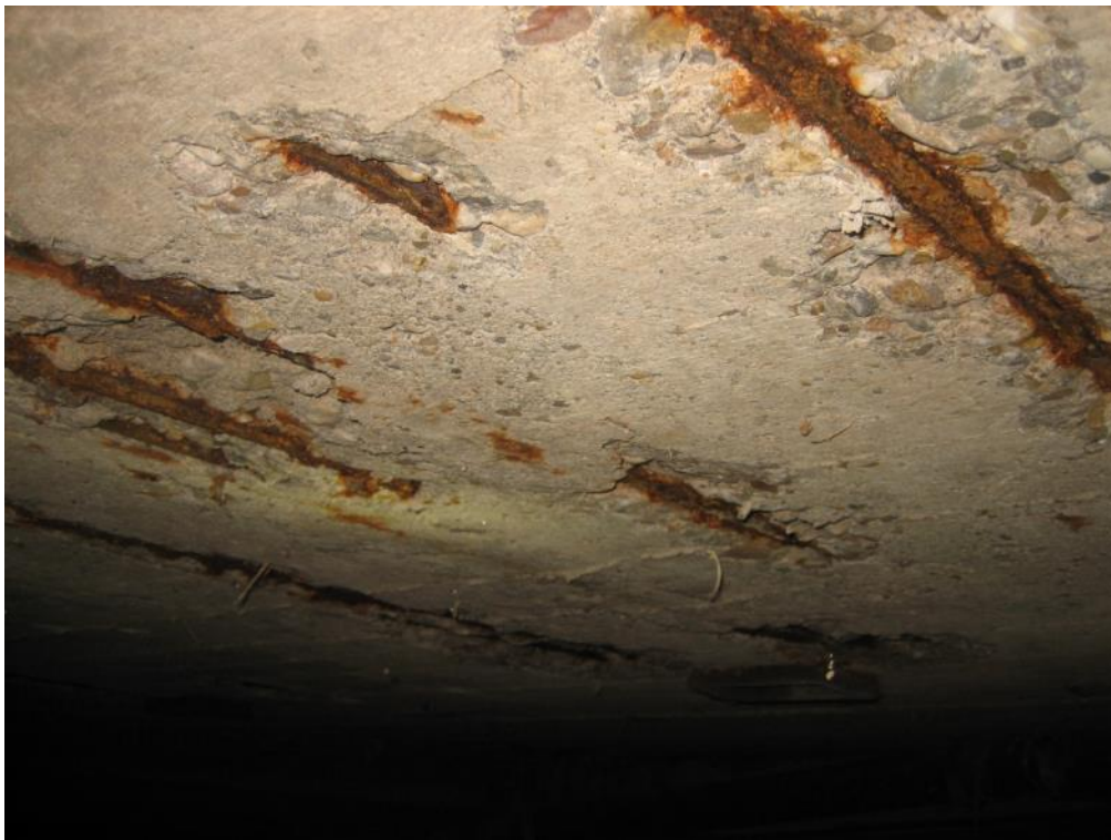
Abb. 42 freiliegende und korrodierte Bewehrung
