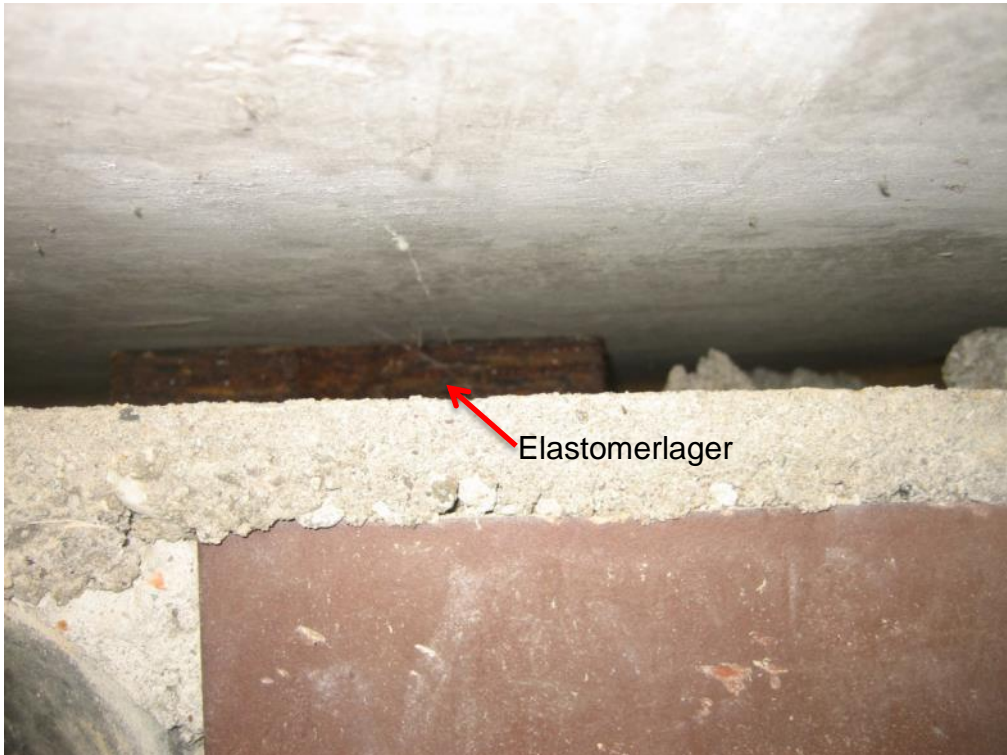
Abb. 57 Elastomerlager
