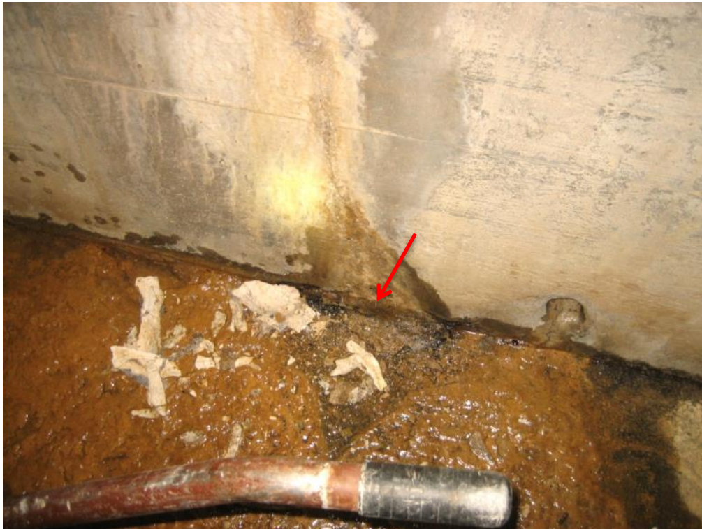
Abb. 51 Wassereintritt im Bereich der Sohle
