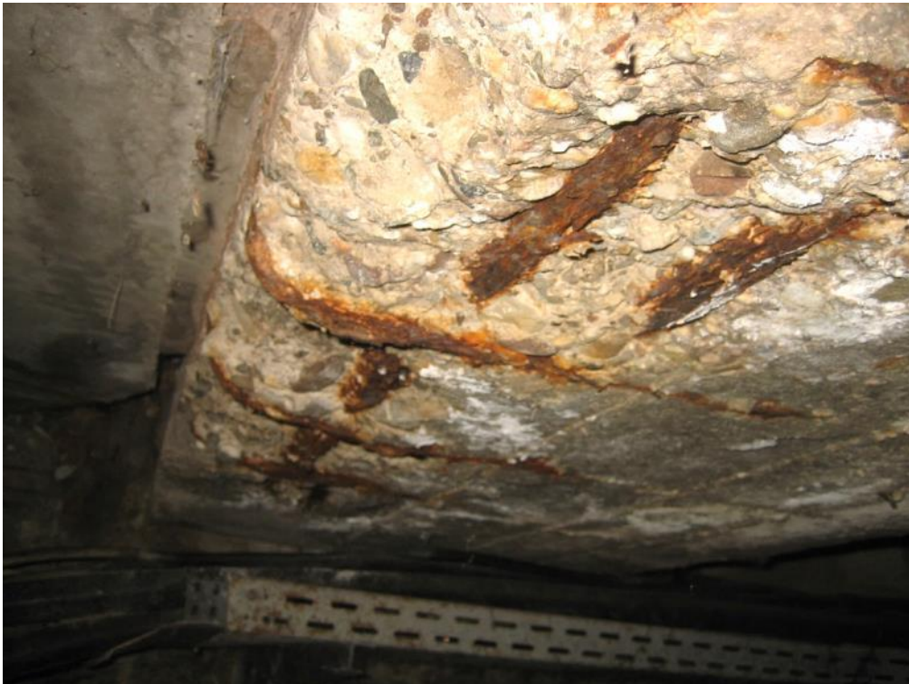
Abb. 59 freiliegende Bewehrung der Unterzuges
