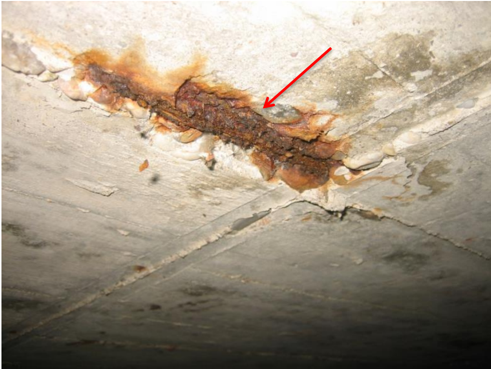
Abb. 17 starke Abrostung der vorhandenen Bewehrung
