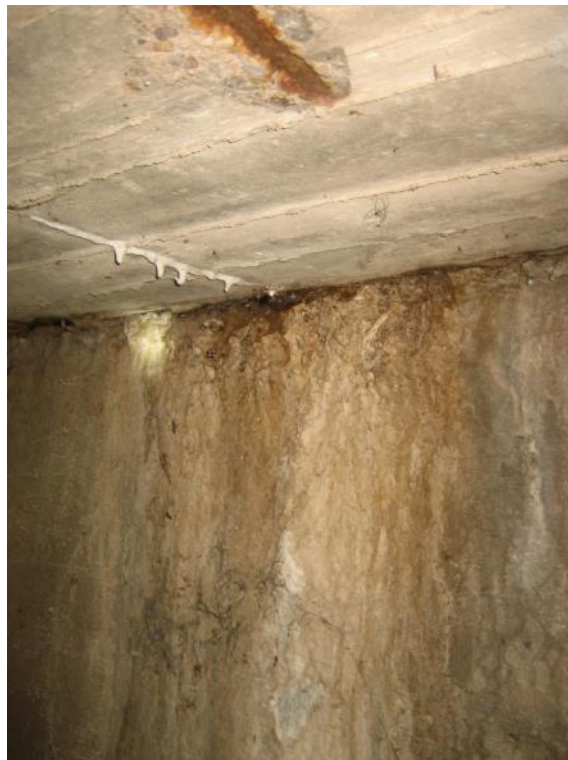
Abb. 50 Wassereintritt im Deckenbereich
