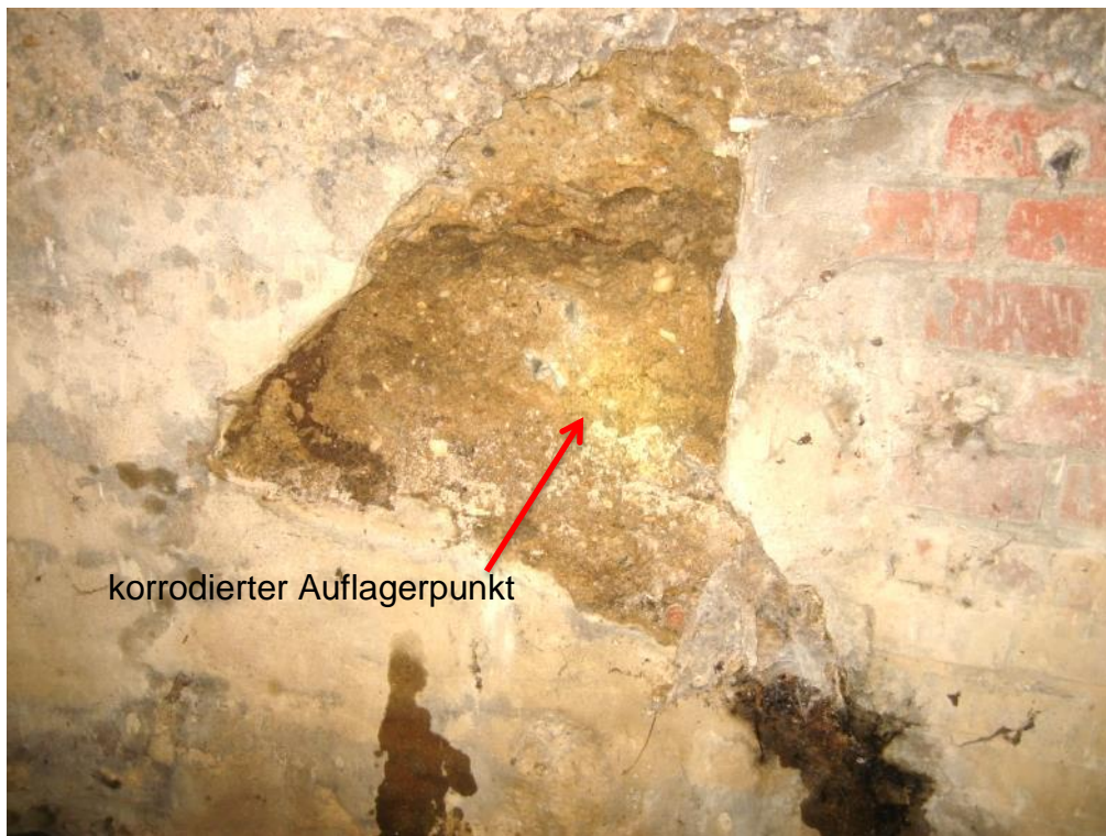
Abb. 38 Durchfeuchtungen am Auflagerbereich
