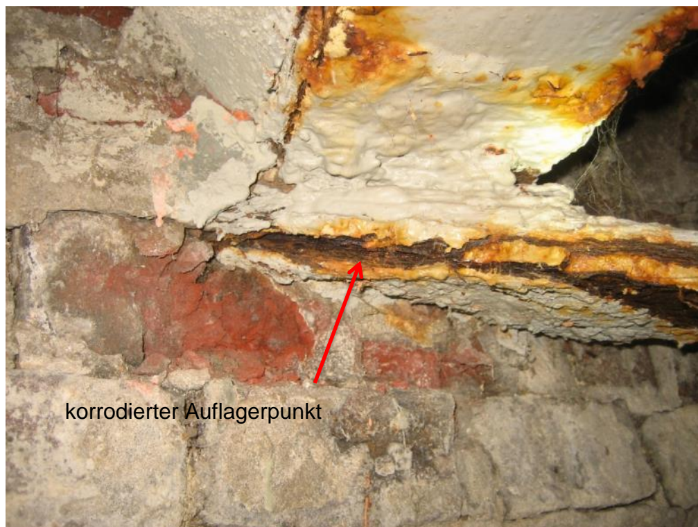
Abb. 36 Auflagerung der Stahlträger
