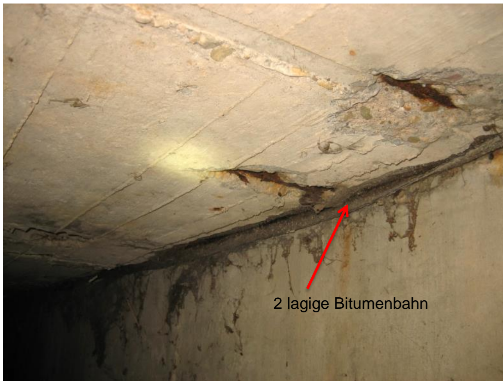
Abb. 49 Übergang Wand- Decke mit Bitumenbahnen
