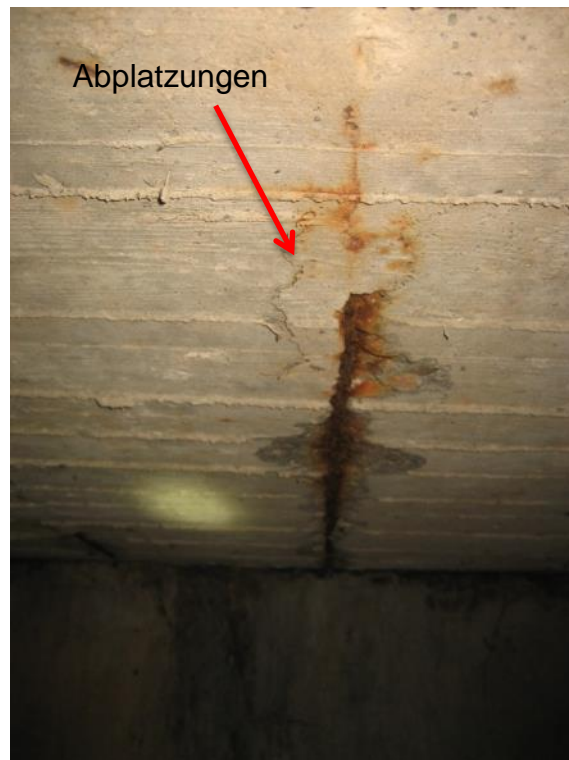
Abb. 43 abgeplatzter Beton und freiliegende Bewehrung
