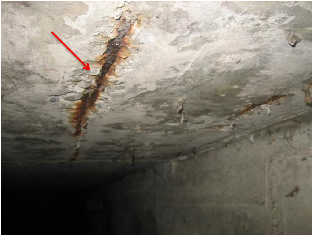
Abb. 16 Freiliegende Bewehrung im Bereich Messpunkt 1
