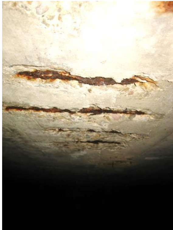
Abb. 18 freiliegende und korrodierte Bewehrung
