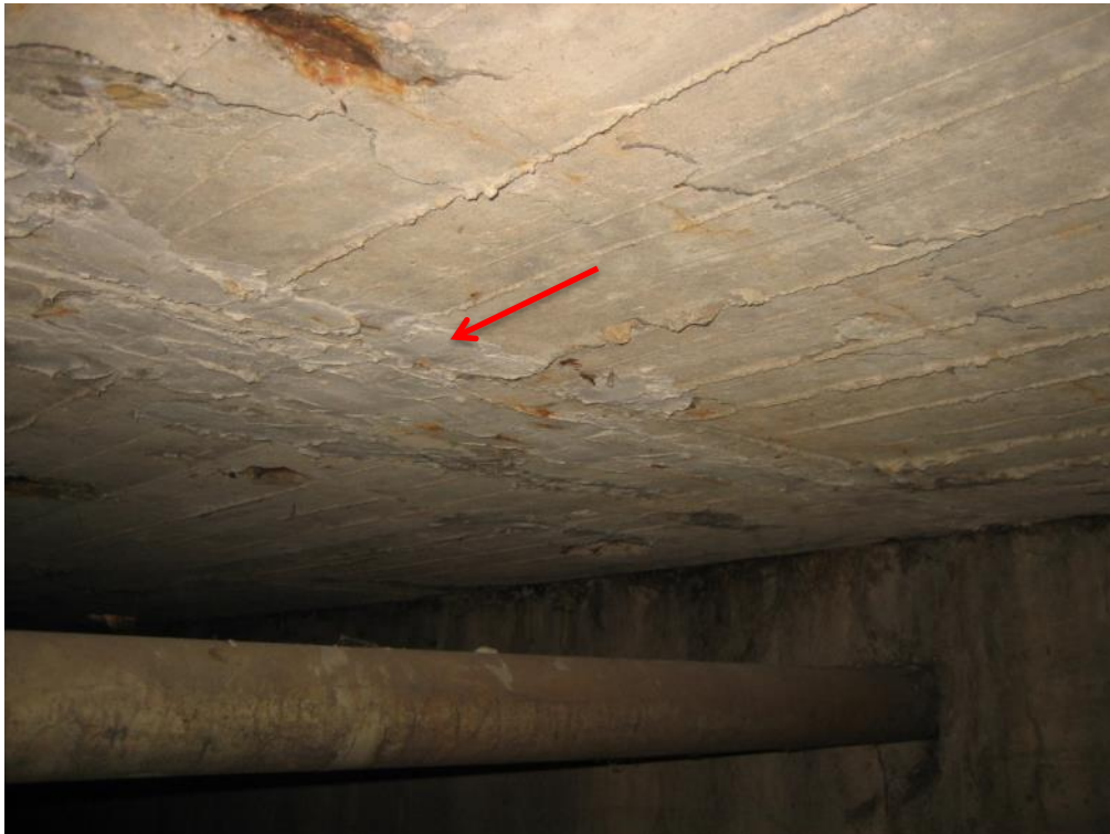
Abb. 44 bereits durchgeführte Betonsanierung
