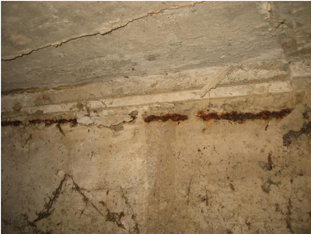
Abb. 24 freiliegende Bewehrung im Bereich des Betonpolsters
