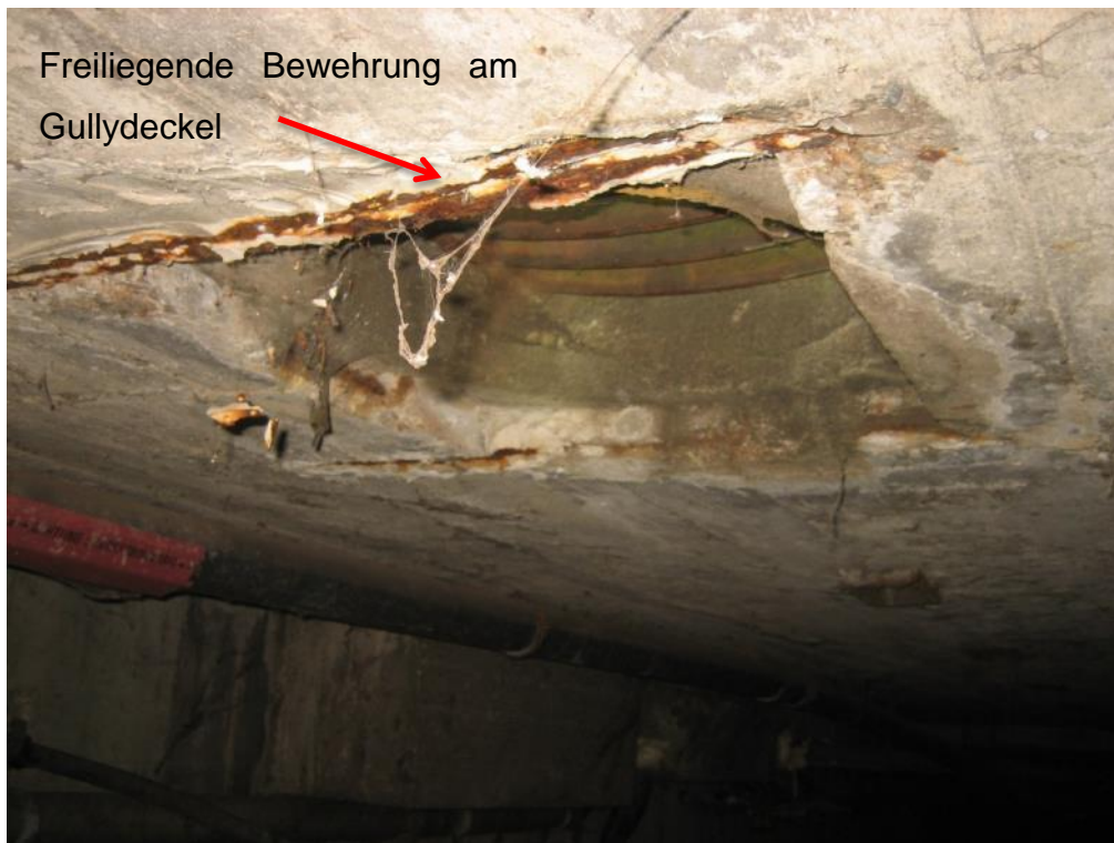
Abb. 45 freiliegende Bewehrung im Bereich eines Gullys
