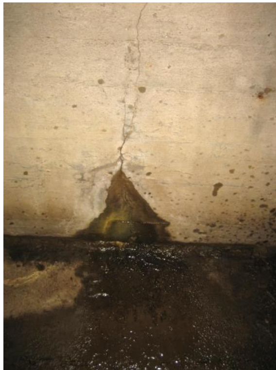
Abb. 52 Riss in der Wand mit Wassereintritt
