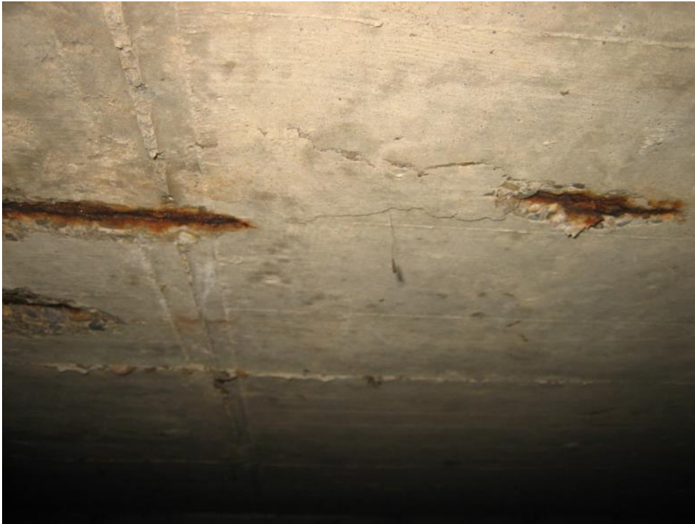
Abb. 19 Betonabplatzungen, freiliegende, korrodierte Bewehrung
