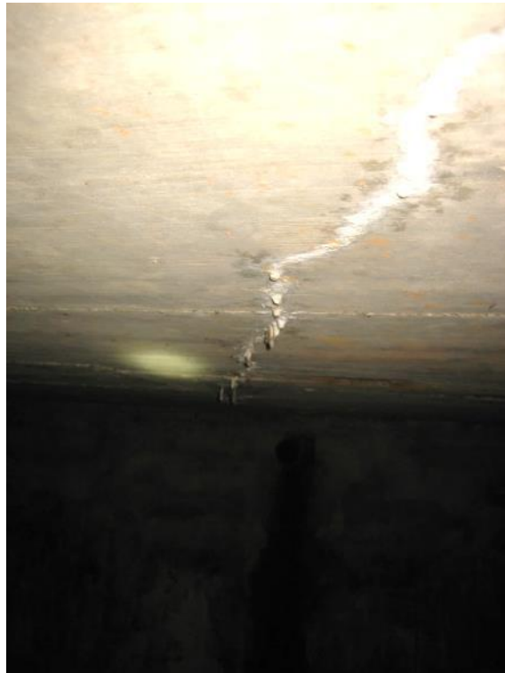
Abb. 29 Riss, längs zur Spannrichtung
